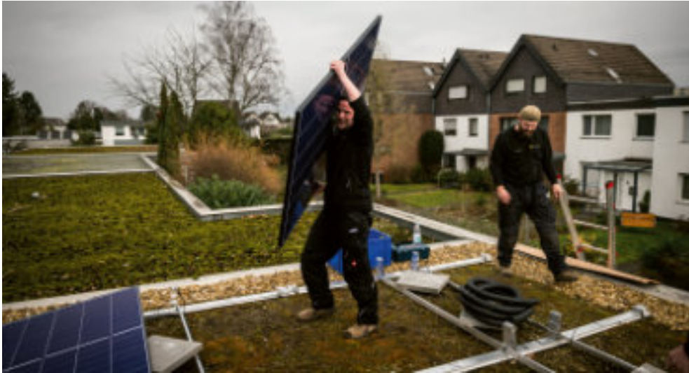
Unsere Partnern von Schoenergie beider Installation einer PV-Anlage auf einem Flachdach im KlimaVeedel Neubrück
